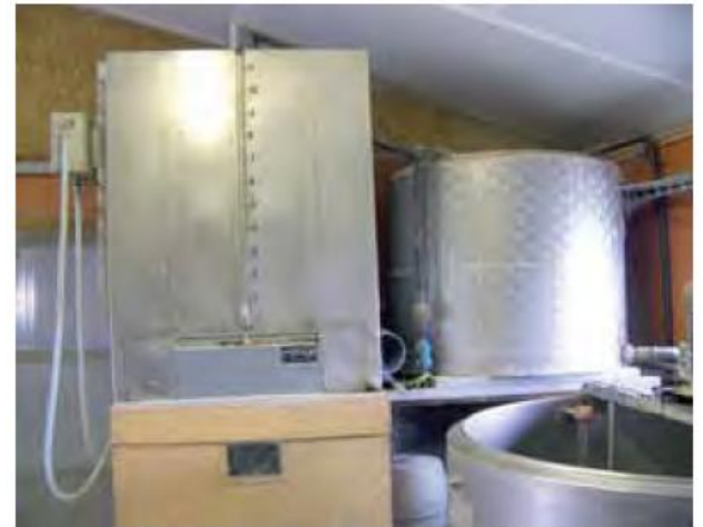
Photo 12: chaudière de type Le PERCY couplée à un réservoir de stockage en inox à pression atmosphérique.
