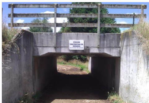
Figure 4 - Illustration d'un boviduc en grande partie auto-construit en Nouvelle Zélande (© Brocard, 2012)
