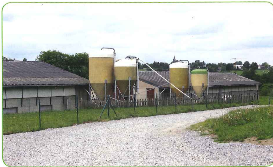
La diversification a été réalisée par l'installation de deux poulaillers Bio de 480 m 2 chacun, à ventilation et éclairage naturels, construits par l'entrepreneur Pascal Lambert de Beauraing.
