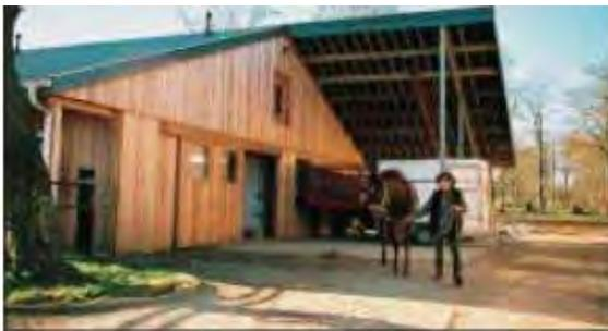
Regrouper au maximum diverses fonctions sous un même toit évite de multiplier les volumes et ce, dans les limites des règles sanitaires. Par exemple, prolonger un versant de toiture en auvent pour le stockage du matériel.
