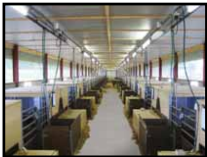
Figure 122: Loge Ethobox, Haka (Source: http://haka.test.intermetrics.de/haka-josef-haeufele-gmbh-co-kg-stalleinrichtungen-ethobox )
