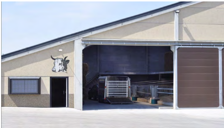
III.40 : Vue sur les installations qui accueillent les veaux lors de leur transition chez le marchand de bétail et sur la remorque de transport, RW, juillet 2021.
